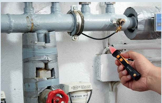
Contrôle de tension sans contact à la boîte de dérivation d'une installation de chauffage au moyen du testo 745.
