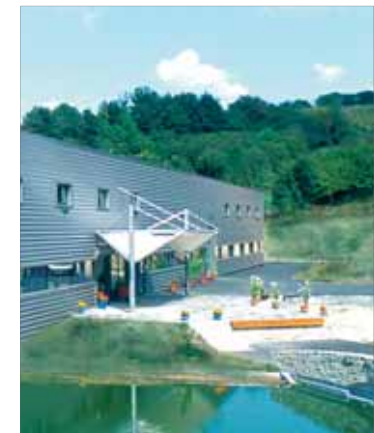
interscience Centre R&D et usine de production
